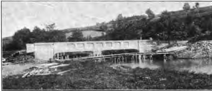
Abb. 84. Schul-Brücke in Raningsdorf (Österreich).
